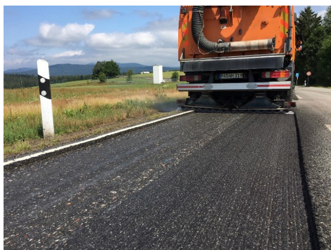
Czyszczenie frezowanej powierzchni
