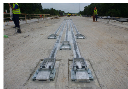
SPRĘŻANIE PŁYTY MOSTU ŁOTWA
