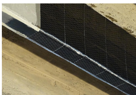
WZMOCNIENIE STREF ŚCINANYCH NAKŁADKI Z MAT WĘGLOWYCH
