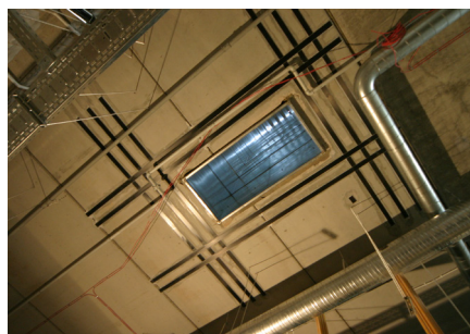
WZMACNIANIE PŁYT POD OTWOROWANIE BIERNE NALEJONE TAŚMY WĘGLOWE
