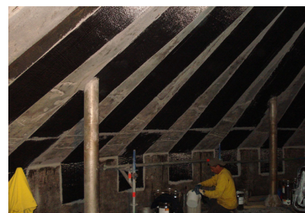
WZMACNIANIE KOPUŁ SIŁOSÓW NAKŁADKI Z MAT WĘGLOWEJ
