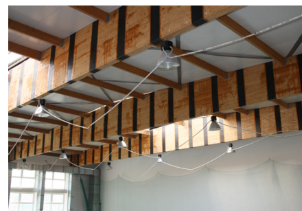
WZMACNIANIE DŹWIGARÓW Z DREWNA KLEJONEGO OPASKI Z MAT WĘGLOWYCH
