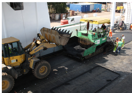
UKŁADANIE SIATEK NA PROMIE ŚWINOUJŚCIE
