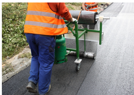
RĘCZNE ROZKŁADANIE SIATEK S&P
