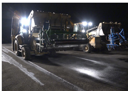
PŁYTA LOTNISKA ŁÓDŹ
